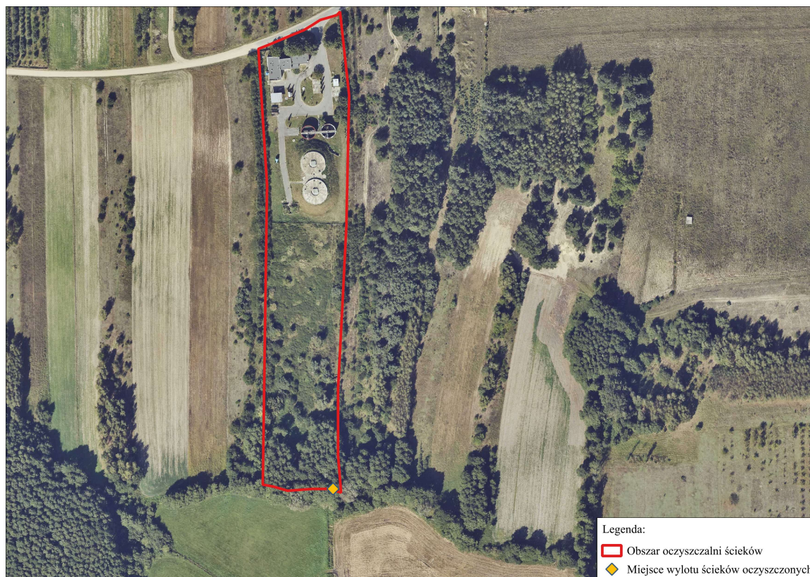
Rysunek 3: Oczyszczalnia ścieków w Tuliszkowie
